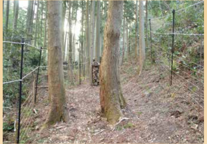
設置が完了したシカの侵入防止柵
