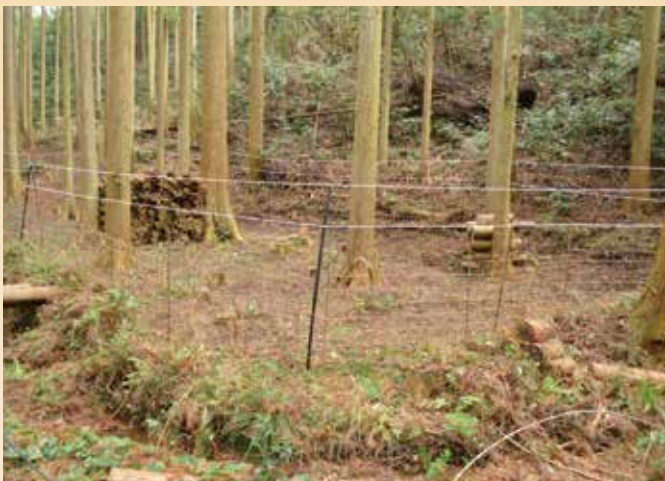
高さ1mのワイヤーメッシュの上に、2mの高さまでロープを張った
