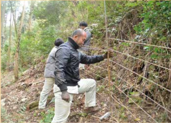
シカを防ぐために柵を張る。金属製のワイヤーメッシュを使用した
